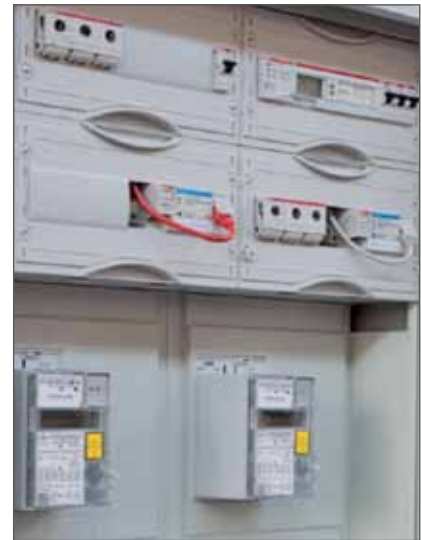
Compteur domestique intelligent pour les systèmes photovoltaïques et autres systèmes apparentés, incluant le comptage divisionnaire KNX.
